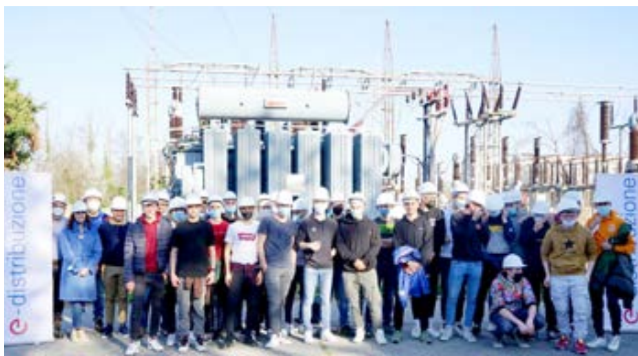
Le classi 5 a A e B in visita alla Cabina primaria del Gruppo Enel
