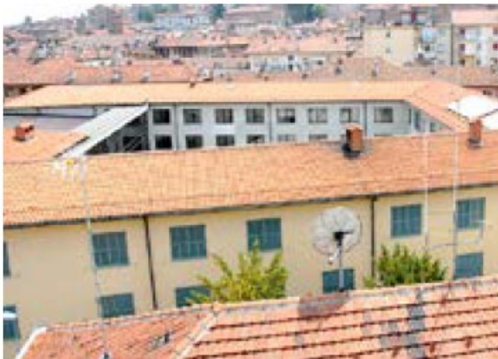
Vista dall'alto dell'edificio di via Donaudi che ospita il liceo Bodoni
